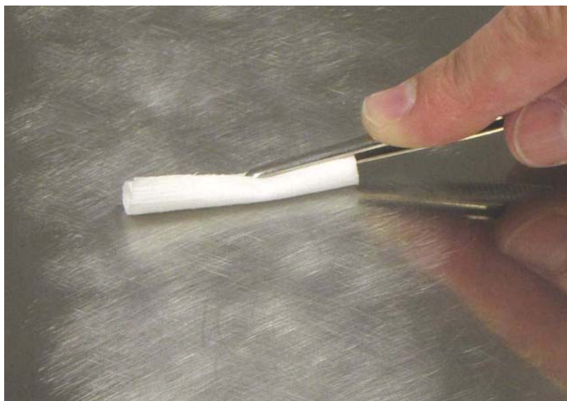
Abb. 2.4: Reinigung der aufgerauten Installationsfläche
